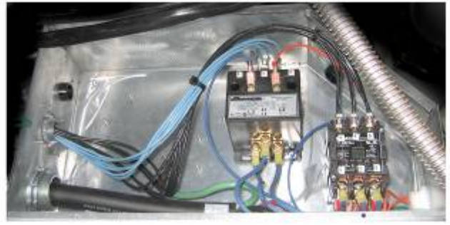
Αριστερή και δεξιά όψη των εξαρτημάτων του μηχανικού κουτιού επαφέα.
